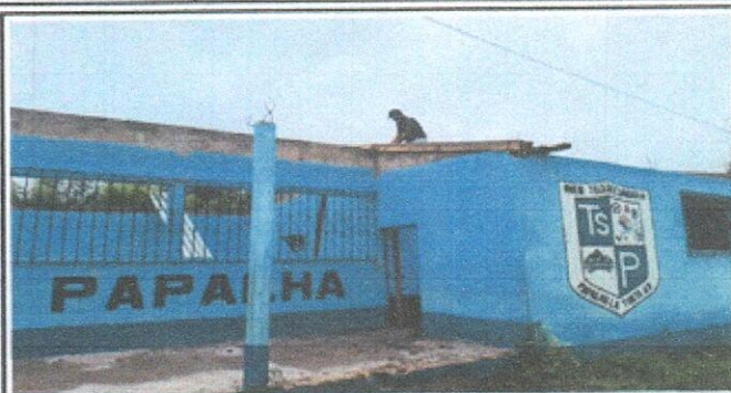
Foto 1: Se quitó el techo y se colocaron 2 hiladas de block para subir de altura.
