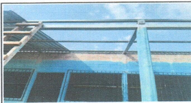
Foto 3: Se observa la colocación de láminas troqueladas.
