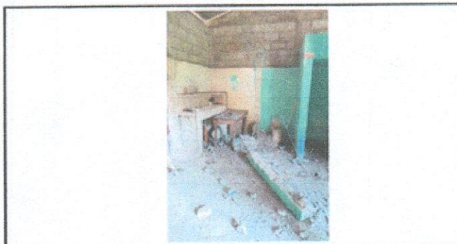
Foto 5: Se elimina el servicio sanitario de adentro.
