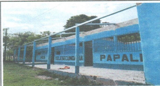
Foto 2: Se observa la colocación de estructura metálica para láminas troqueladas.
